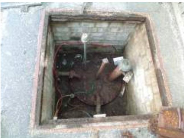
Foto 9: Domschacht DK-Erdtank, unauffällig
