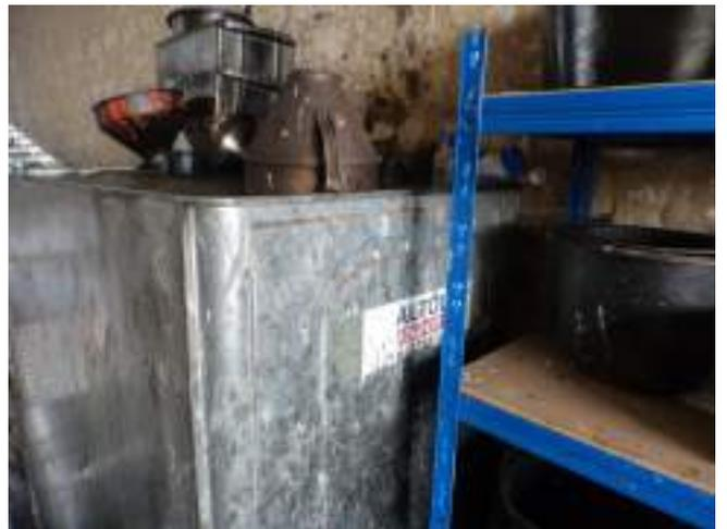
Foto 14: Doppelwandiger Altöltank, Ersatz für den 1992 beanstandeten Altöltank.
