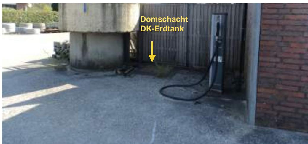
Foto 10: DK-Zapfsäule und Abfüllfläche, keine Auffälligkeiten, laut Eigentümer ist DK-Tankstelle seit 10 Jahren ungenutzt, aber weiterhin betriebsbereit geprüft.
